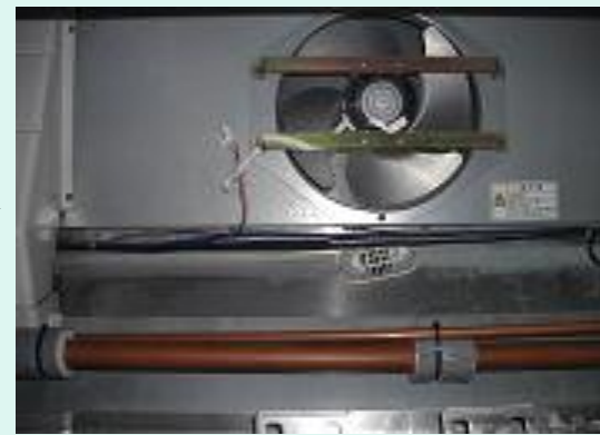
デッキパン部洗浄後
