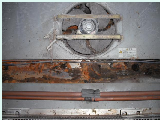
デッキパン部洗浄前
