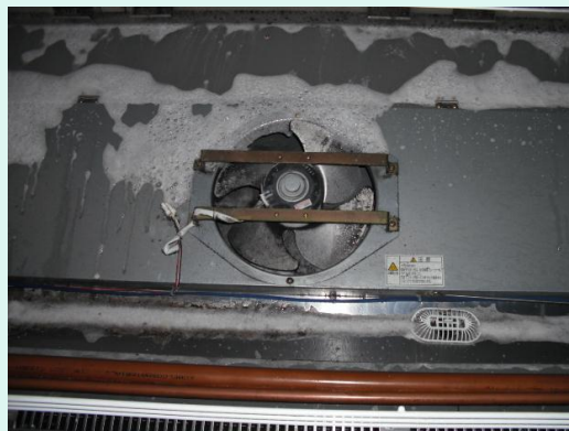
デッキパン部洗浄中
